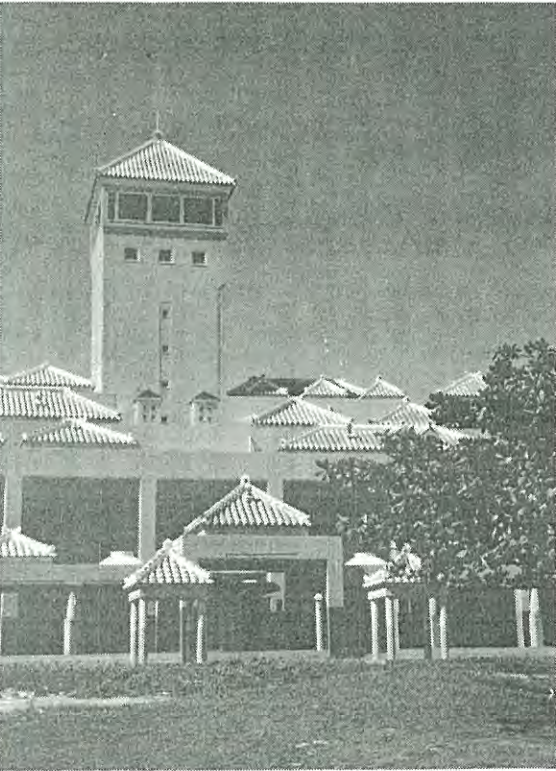
地上高さ24mに設けられた展望室
