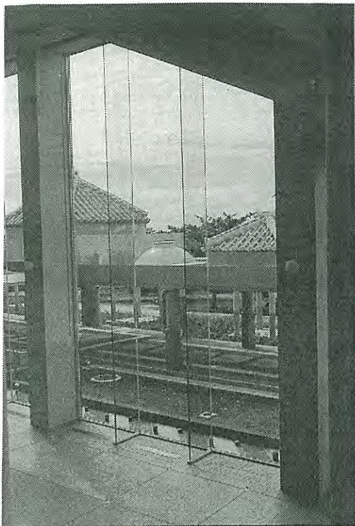
平和の礎側にあるホールの大開口アルミサッシの内観と外観
