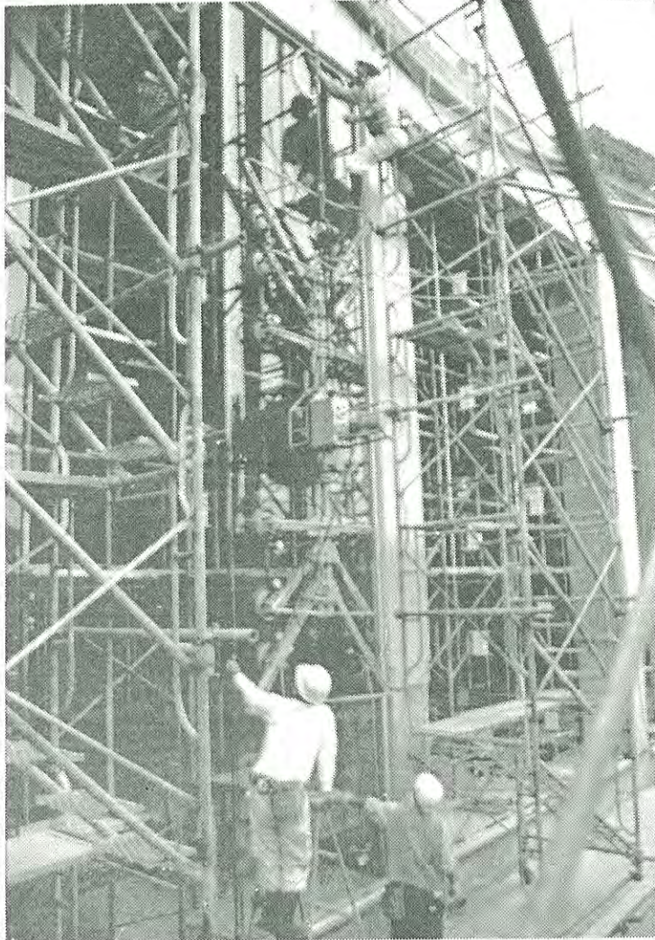
7.4×1.7m(厚さ25mm)の特注大板ガラスのはめ込み作業
