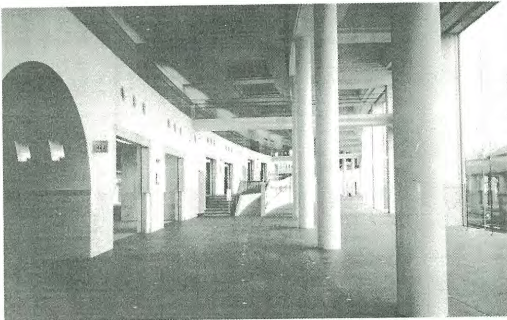
建物内部。設計者施工者の納得のいく「納まり」に仕上がった
