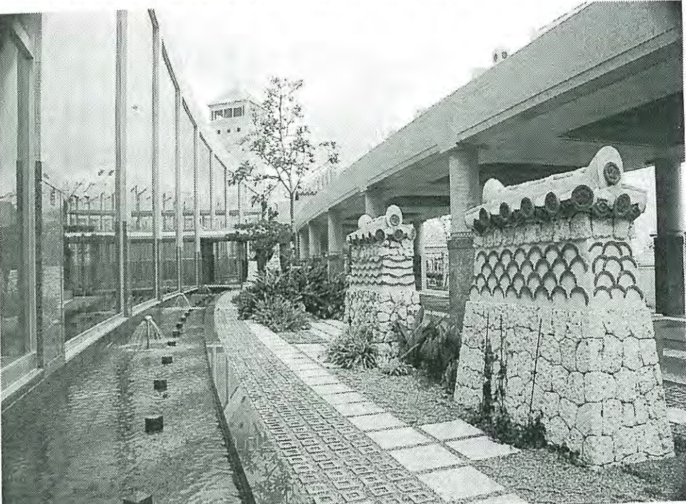
日本本土とは異なる亜熱帯地域に建つ平和祈念資料館の一部
