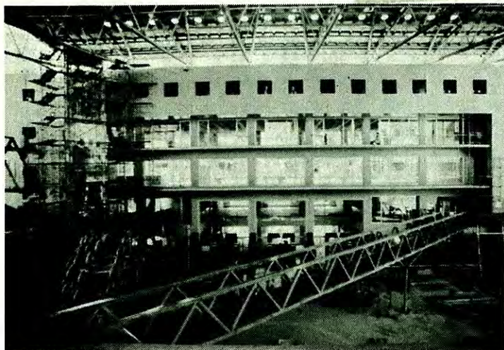
沖縄総合福祉センター(仮称)が竣工し、オー た人はガラスがたくさん
