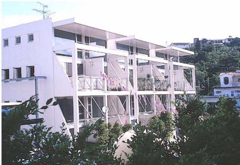
浦添大平にあった4階建て12戸のメゾネット式アパート。17坪の極小住戸だが、広めのテラスや緑、内部の吹き抜けによって狭さを感じさせない。オープンな住戸は住人のお気に入りだった。
