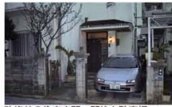
改修前の住宅玄関。門柱と駐車場
