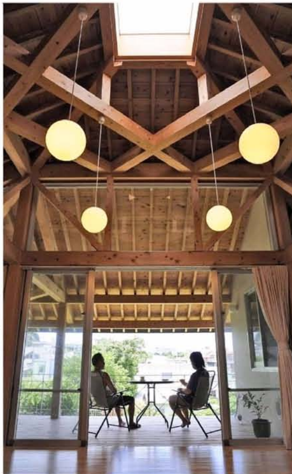
2階は木造で開放的な和室とLDKとテラス。上部にトップライト、檜材の柱・梁や屋根裏が見え、沖縄の台風にも耐える木構造
