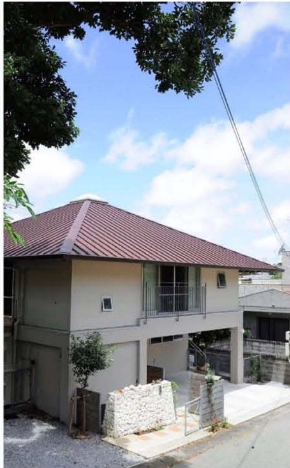
混構造の住宅の外観。屋根は鉄板瓦棒貫寄棟屋根をもつ。1階は強固なRC造で主寝室・書斎・バスルームなどの個室がある
