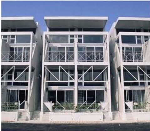
10mの高さ制限地区・浦添大平にあったアパートは上下に部屋があるメゾネットの4階建て、階高は2.3m。下階にはLDKとバスルーム、上階に寝室2室と納戸
