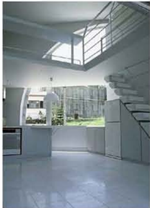
2階のLDK。上部に見える3階の書斎床は無梁スラブ。床は大理石敷き、壁・天井はペンキ仕上げ
