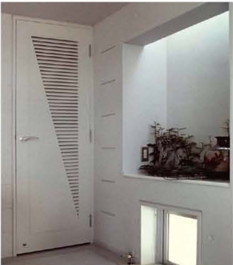
壁も天井もコンクリートに塗装仕上げ。内装を全てで統一し材質感をなくすと、コストも下がり美しく見える
