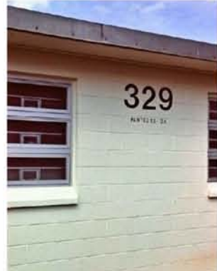
外壁に建物番号と塗装の日付がある米軍基地内の住宅。しっかり維持管理し長持ち
