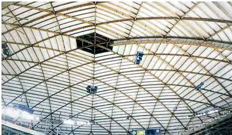
タマゴドーム (アメリカワシントン州、1982年竣工)。集成木材を使った直径160メートル、高さ46メートルの巨大なドーム。日本でも、従来コンクリート造だった学校、集合住宅など大規模な建物も集成木材でつくられるようになった
