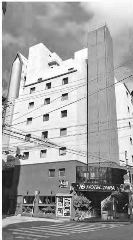
ホテルタイラ。1975年竣工、狭小敷地に最大限のホテル建築を構造デザインの力で実現。当時の電信電話公社のIBM大型コンピューターを使って構造解析した。40年経つ今も美しく維持管理されている。
