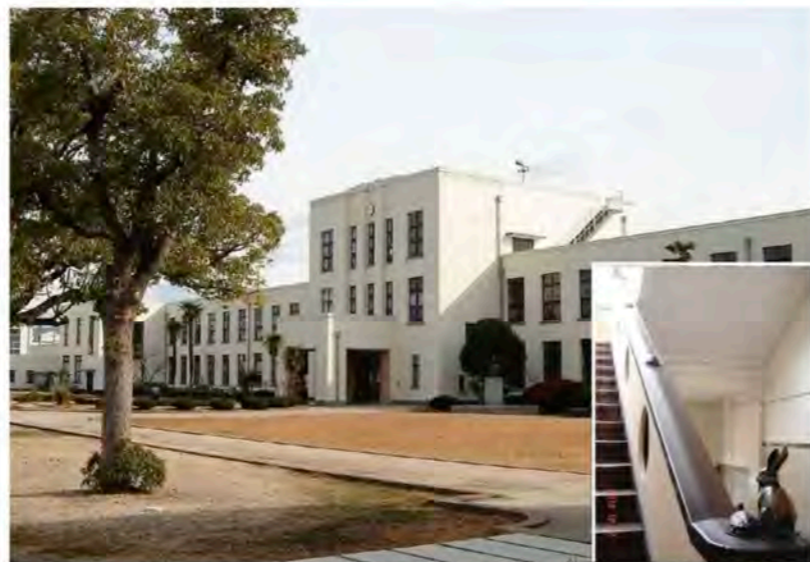
元豊郷（とよさと）小学校（築86年）。1937年卒業生の実業家・吉川鉄治郎（1880～1940）が私財で建設し寄付。設計は滋賀近江八幡在住の建築家W. M. ヴォーリス（1880～1964）。鉄筋コンクリート造で最新の暖房設備などが施され、「白亜の殿堂」や「東洋一の小学校」と呼ばれた。階段の手すりにはイソップ童話にある「ウサギとカメ」のブロンズ装飾がある（右下写真）
