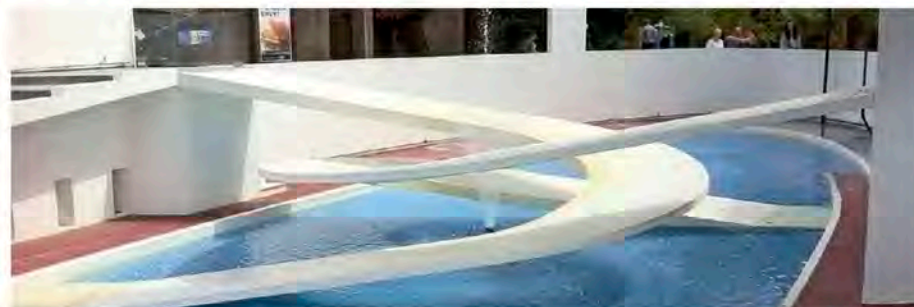
上下写真：ロンドン動物ペンギンプール。1934年竣工、建築家パーソルドリュペトキン、構造家オプ・アラップ。プールの上になせん型の2本のスロープが交差する独特の構造。当時、新素材の鉄筋コンクリート建築の可能性を示すものとして評価された。(写真提供 上：ロンドン動物園、下：ワキ・ヒロミチ)
