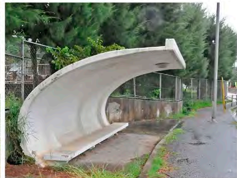
セメント工場前バス停の側面写真。根元200mm厚、先端80mm厚の曲面屋根スラブには3カ所のリップと先端梁がある。先端部分は地面から高さ2.1mほどしかなくコンパクトで、ベンチに座れば囲われているような不思議な空間を感じる
