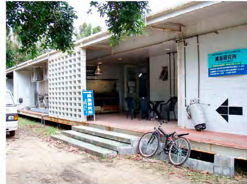
「黒島研究所」1974年竣工。小さな離島で建築資材の運搬の問題があり、鉄骨プレハブ造になったと思われる。床を地表面から持ち上げ、屋根はフラットルーフにしたシンプルな構造。壁はコンクリートブロックや花ブロックを採用した。（同研究所HPより）
