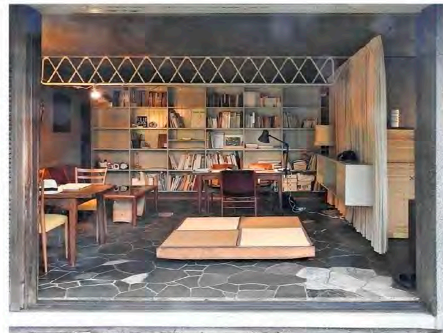
「私の家」1954年竣工。戦後、個室のある住宅が主流になる中で、日本の伝統的木造住宅に似たワンルームのモダン小住宅を提案。大きな開口で庭と連続。床は鉄平石敷、天井はRC打ち放し、内部の壁は人研ぎ仕上げ。開放的な空間構成は沖縄の伝統的木造住宅にどこか似ている。
