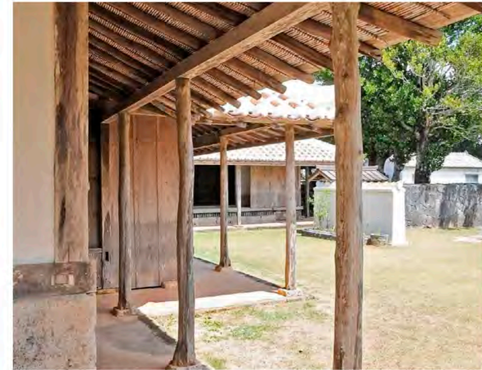
雁行(がんこう)する雨端。柱はチャーギ、丸太垂木、山原竹の野地、台所の腰壁は石積み、壁は漆喰塗り壁
