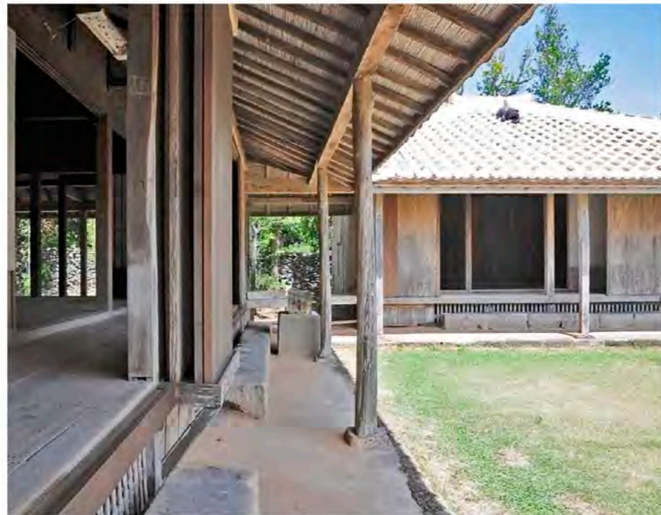
雨端の納まり。縁側と雨端のスパンは1050mm、軒の出は600mmと一般的だが、軒先は地面から2100mmと低い
