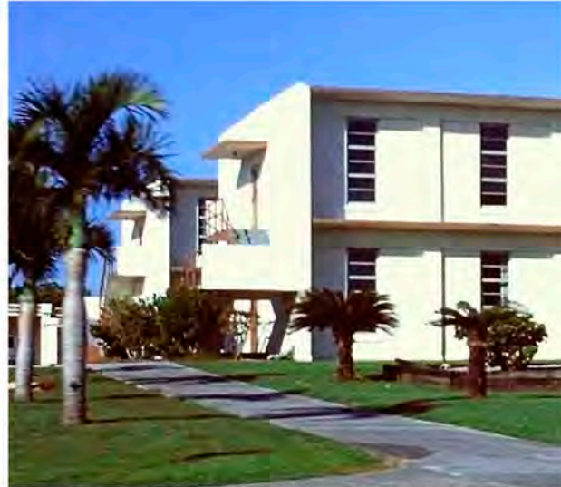
米軍基地内宿舎 70年余前の建物であるが数年ごとの外壁塗装などメンテナンスが行き届いているため、今でも健全な状態。
