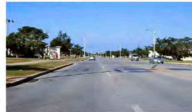
上下：嘉手納基地内の幅広の道路。
