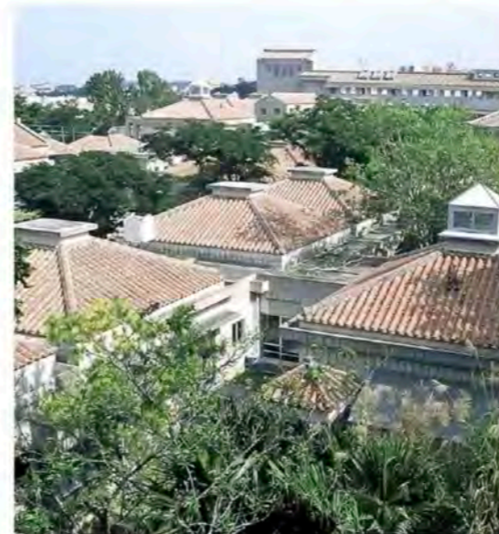
城西小学校 (1986年、原広司) 首里城が復元される前に計画・建設された。各教室に赤瓦屋根を載せ、首里城周辺の景観を誘導した
