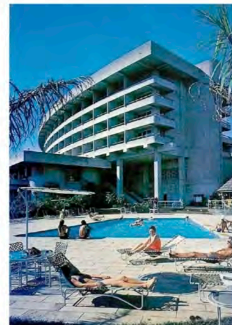
沖縄ヒルトン時代の屋外プール (ポストカード)
