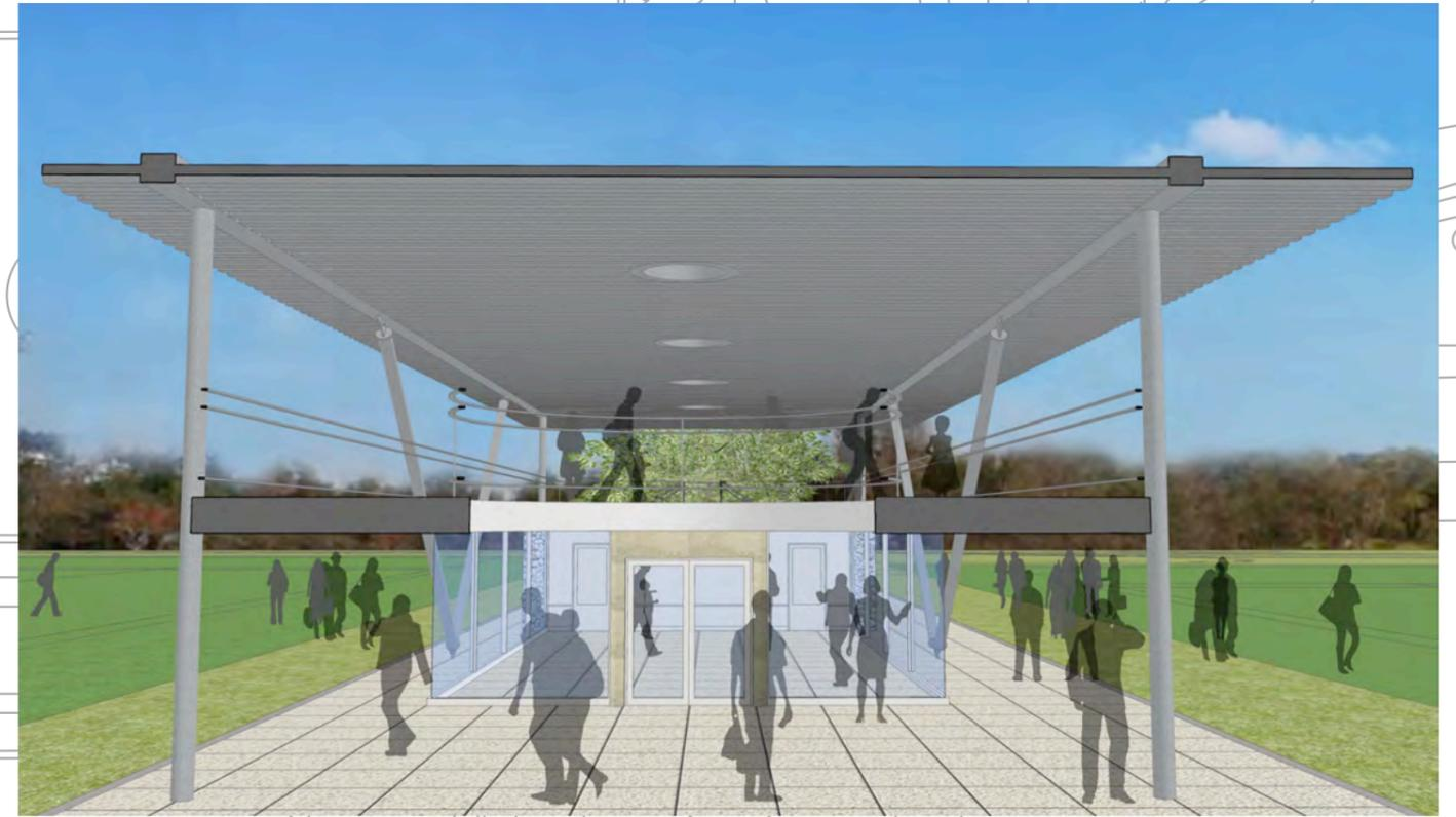
地上レベルは構造コアとなる諸室を設け、2階レベルの観覧デッキは構造コアと外周の鉄骨フレーム、大屋根は鉄骨フレームにより支えられる単純明快な構造である。また、将来的な増築も容易である。
