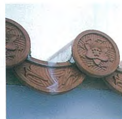
左／琉球赤瓦屋根・島棟(大棟)の先端の島面。 (鬼瓦に相当する) 右／軒先の文様入り軒丸瓦と軒平瓦。
