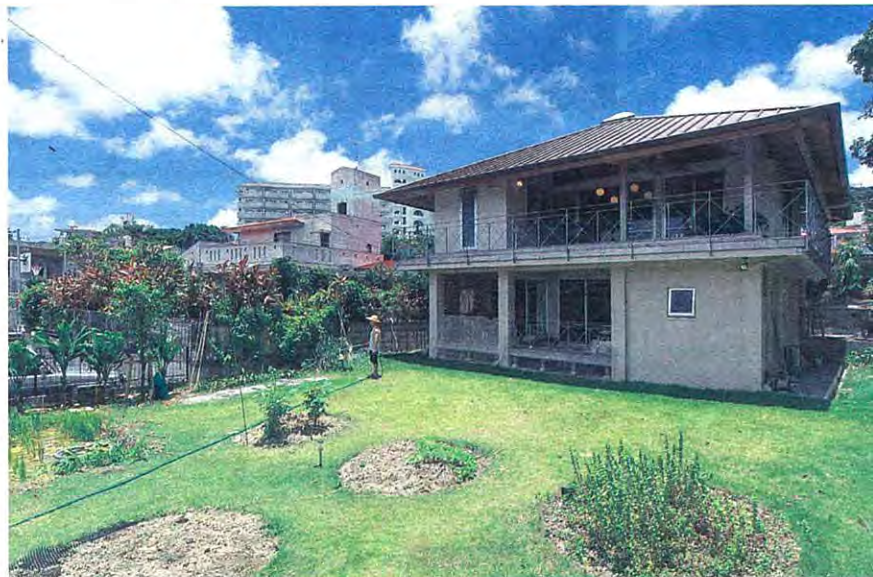
敷地南側、庭から見た外観。えんじ色の屋根は、鋼板製の方形屋根。左端には、Tさん念願のトンボを観察するための田んぼが見える
