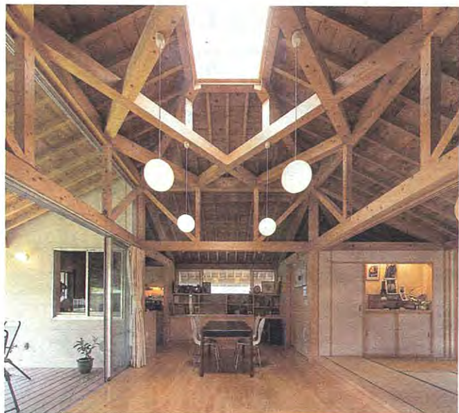
2階テラス、リビング・ダイニング、和室のつながりを見る。屋根全体が室内はもとより、テラスまで覆っているように見える。木造部分は、柱や梁がむき出しになった真壁(しんかべ)工法で造られている
