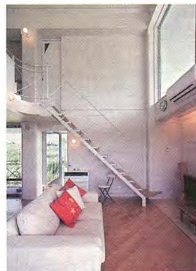
リビング。壁面はコンクリートブロックやガラスで、ローコストで仕上げた
