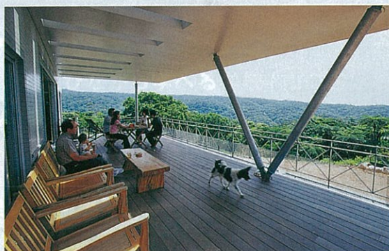
居住空間とほぼ同じ広さのテラスが居間代わり。台風や潮風による吹き上げが強いので深い軒は頑丈なコンクリート製に。
