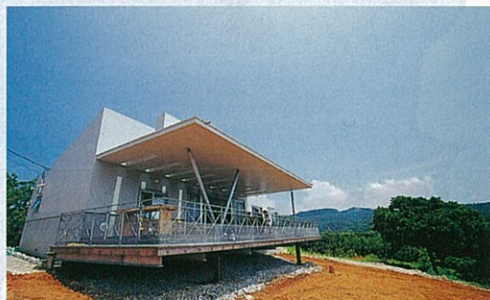
造成は最小限にして斜面に突き出すようにテラスを設けた。塩害防止のため、コンクリート外壁をタイル張りに。
